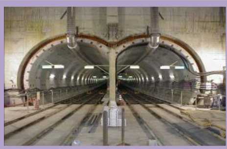
↑捷運潛盾隧道
